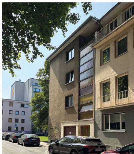
Am Römerturm 7 im August 2025 vor Aufstockung
